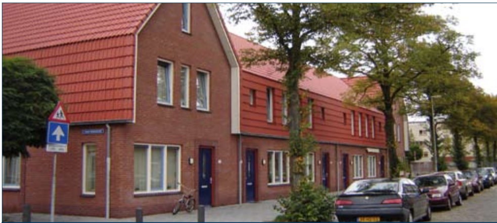
In de wijk Ondiep in Utrecht realiseerde BAM Woningbouw onlangs 36 zogeheten W&R-woningen; nog eens 36 woningen zijn in voorbereiding. W&R is een door BAM ontwikkeld gestandaardiseerd bouwproces waarbij de leidende principes al worden toegepast.
